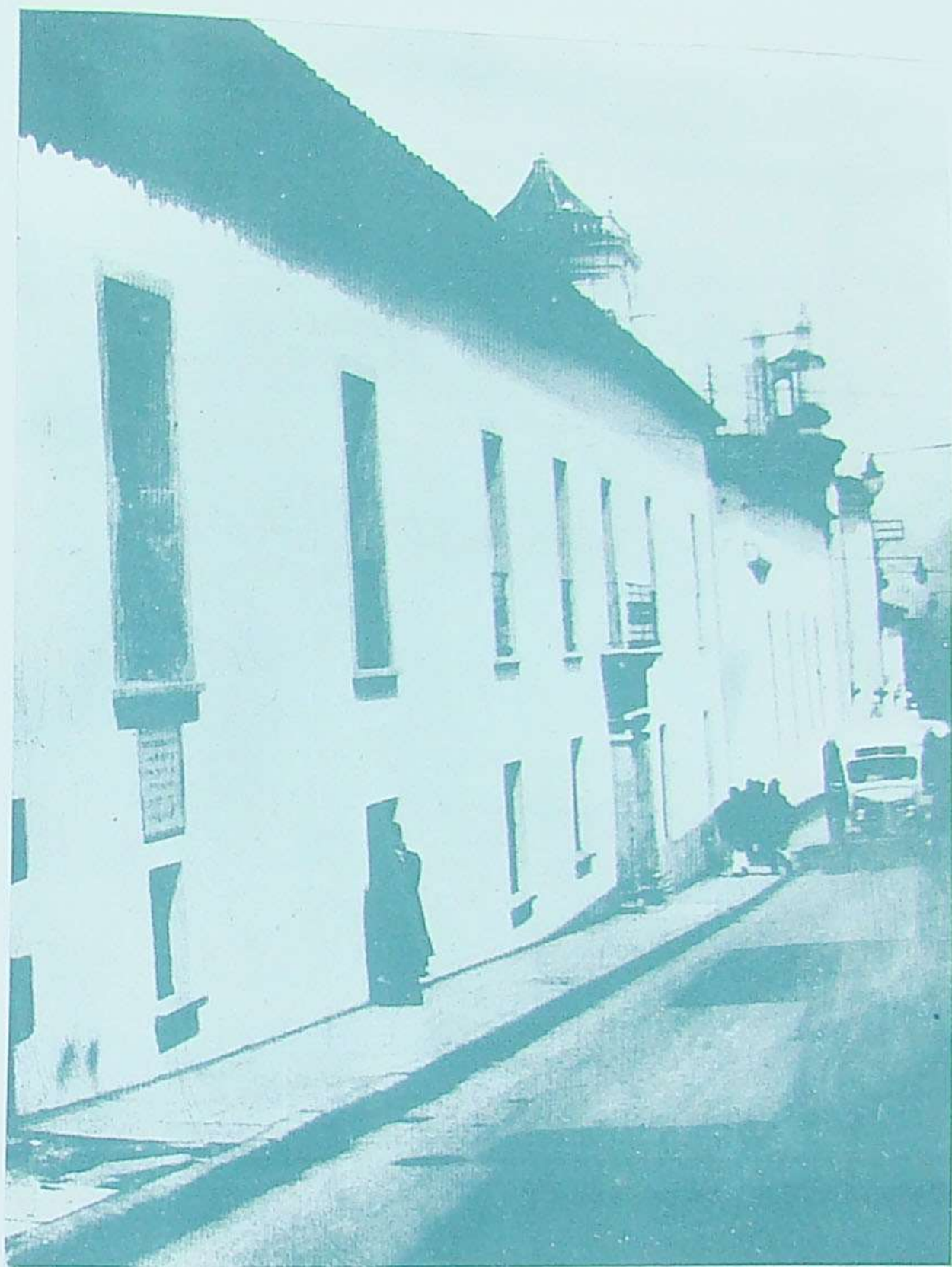
Vista parcial de la Fachada del Palacio de San Carlos, en la Capital Colombiana
