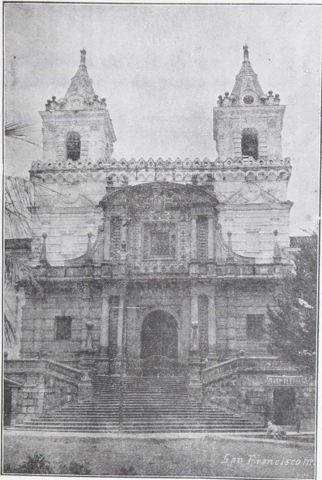
Fachada del Templo de San Francisco
