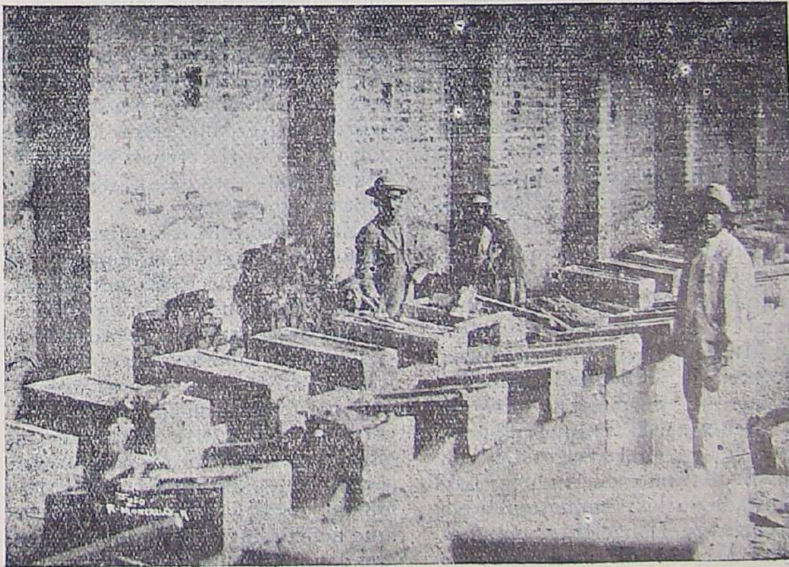
Sección de lavanderías, en construcción, en el edificio de la Avenida Colombia.
